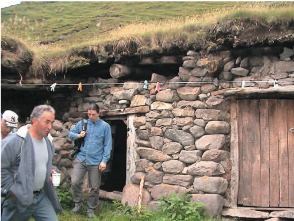
図 519. バルカリアンの家。ドアとドア枠が一帶になって作られており、それを「イツシキ」(一式)と言う。
